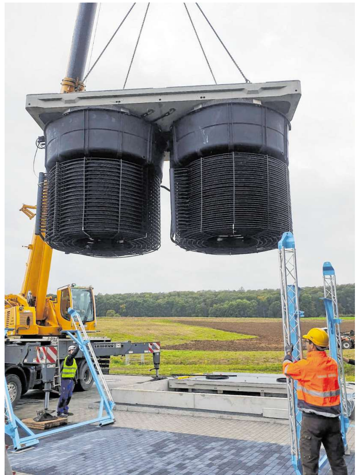
Der Naturwärmespeicher wird fachmännisch eingelassen. BILDER: KLAUS T. MENDE
