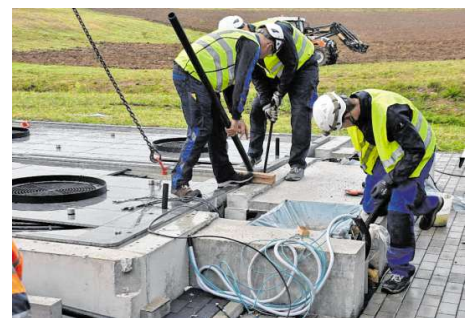
Die Fachleute sind dabei, die Anlage anzuschließen, damit sie rechtzeitig zur Eröffnung des Marktes ihre Arbeit aufnehmen kann.
